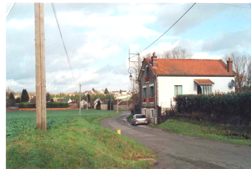
L'entrée ouest, depuis la voie ferrée.
