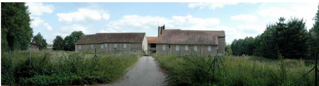
La ferme de Plantoignon d'une architecture typique de la région
