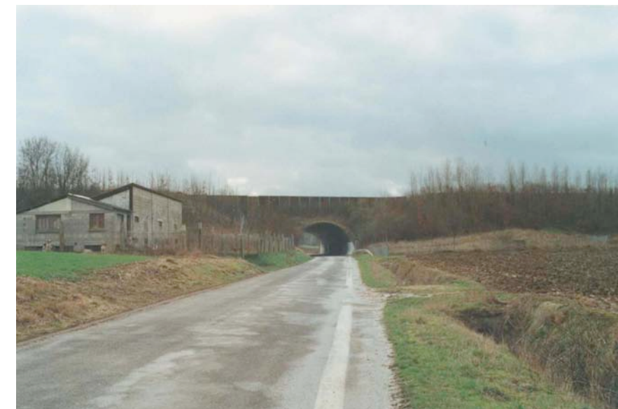
Exemple de coupure occasionnée par les grandes INFRASTRUCTURES dans la vallée (ici A16)
