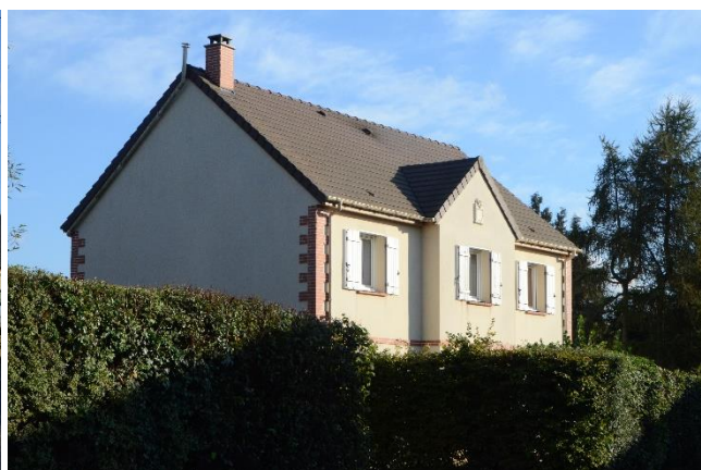
Construction individuelles contemporaines à La Longue Rue
