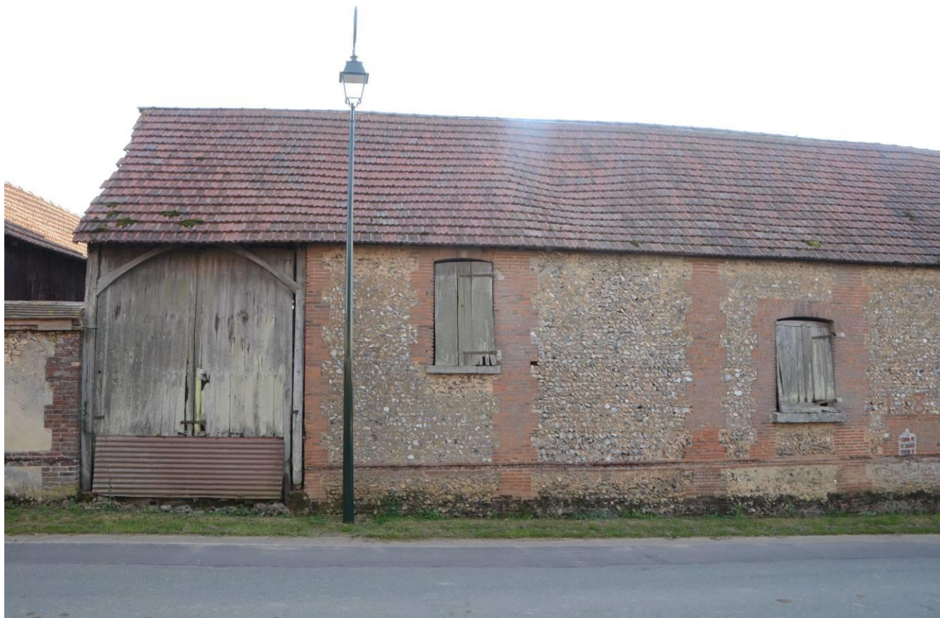
Bâtiment agricole pouvant changer de destination
