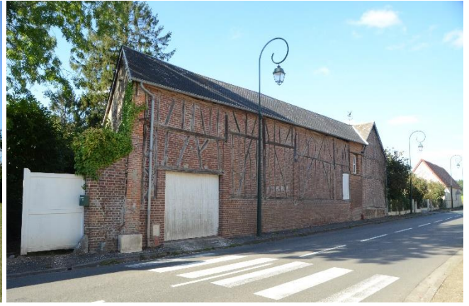
Exemples de constructions anciennes de qualité
