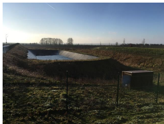
Photo 9 – Bassin techniques (Alisea 2020)
