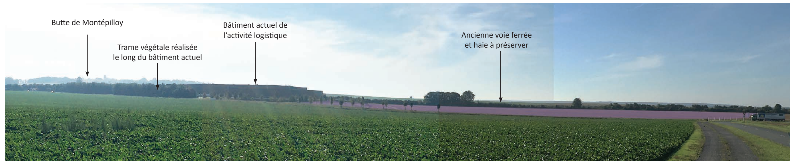
Depuis l'entrée sud du village par la RD134, vue sur l'emprise de la zone 1AUe proposée au PLU révisé.
