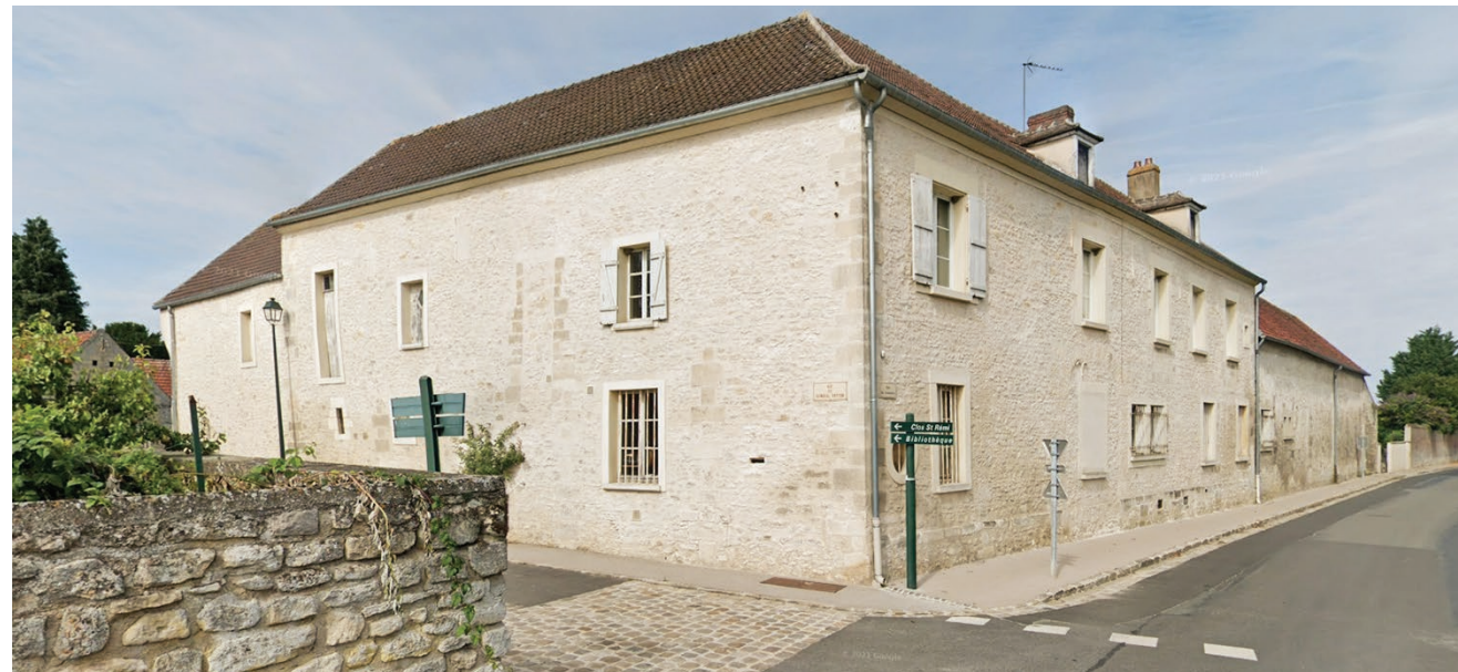
Vue sur les bâtiments présentant un potentiel de reconversion en logements rue du Général Patton rue des Tournelles.
