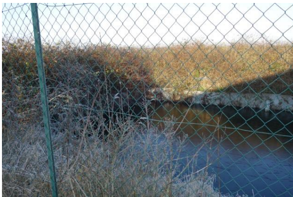
Réservoir d'eau – Zone 1 Np
