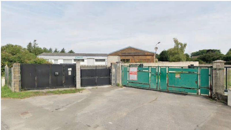
Vue sur des bâtiments d'activités présents sur la zone de la Logette.
