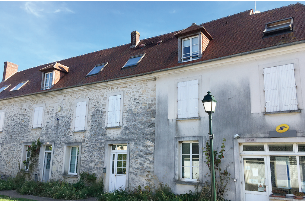
Logements locatifs communaux réalisés à côté de la mairie.
