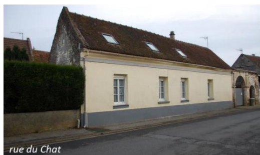
Travaux de ravalement
