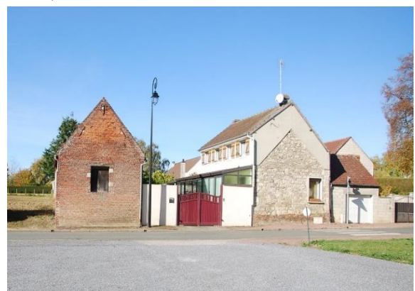
Figure 30: Extension dénaturant le caractère du bâti ancien, Grande rue
