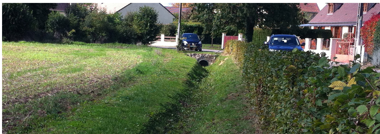
Fossé drainant aménagé chemin des Harnoulds.
