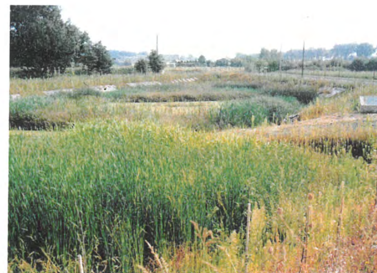
Bassins plantés de roseaux et typhas (STEPH de la flèche)
