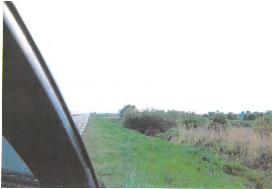
RN 31 ( effet longiligne et rectiligne de la voirie)
