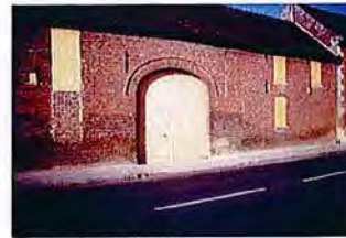
Grange avec porte charretière
