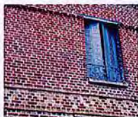
Brique rouge, brique silico-calcaire blanche
