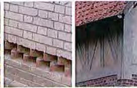
Jeux de brique créant une aération
