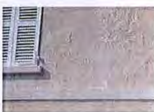
Ravalement d'enduit sur moellon
