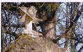
Pinnacle en pierre au dessus d'un puits
