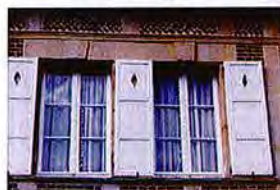
Brique chevron, linteau pierre
