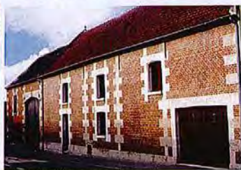
Réutilisation d'une grange en logement
