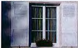
Feuillure autour d'une baie
