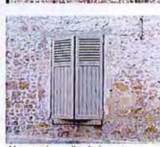
Maçonnerie moellon à pierre vue
