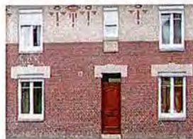
Mur en brique rouge et silico-calcaire
