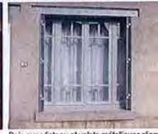
Baie avec linteau et volets métalliques plantés
