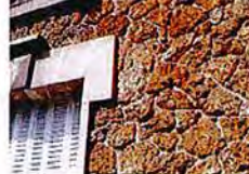
Meulière avec joint creux au mortier bâtard
