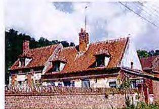
Cheminées massives et lucarnes à capucine
