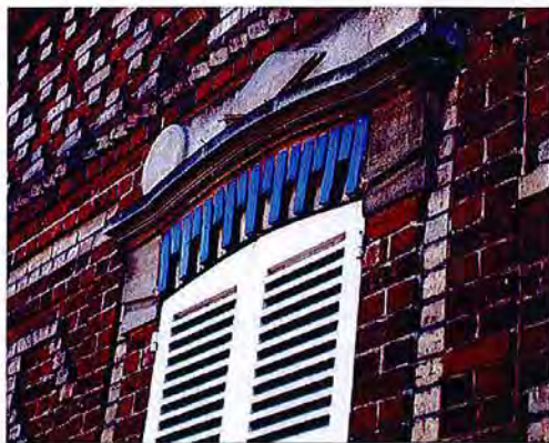
Brique rouge, silico-calcaire, vernissé bleu
