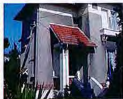
Entrée avec auvent en tuile mécanique
