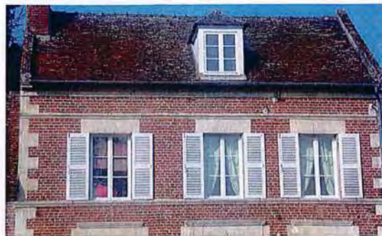
Maçonnerie mixte, volets peints persiennés
