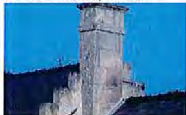
Souche de cheminée en pierre de taille
