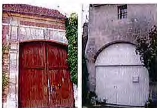
Porche d'entrée avec encadrement ouvragé en pierre
