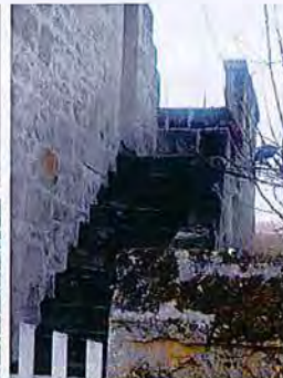
Escalier en pierre sur pignon
