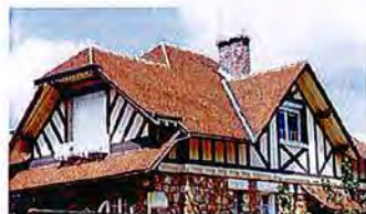
Mouvements de toiture: croupes, noues, ornementations sur les rives et les foibles
