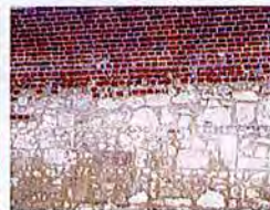
Brique et moellon calcaire
