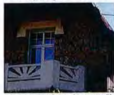
Balcon en béton d'une maison en meulière
