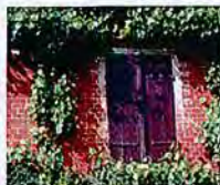
Brique recouverte d'un lait de chaux
