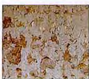
Enduit ancien sur moellon
