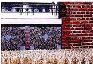
Modénatures : céramiques, bandeaux, corniches, harpes, encadrements
