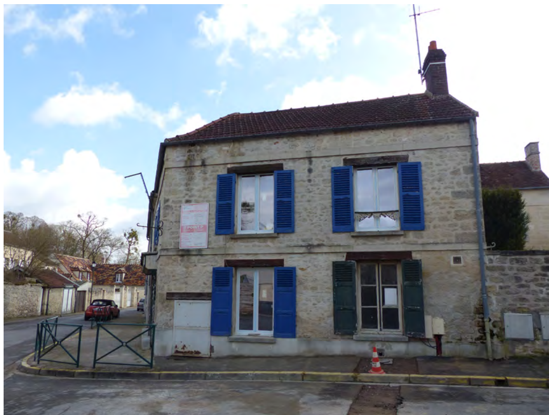
L'ancienne auberge d'Agobert, sur la place d'Avilly, est aujourd'hui fermée.
