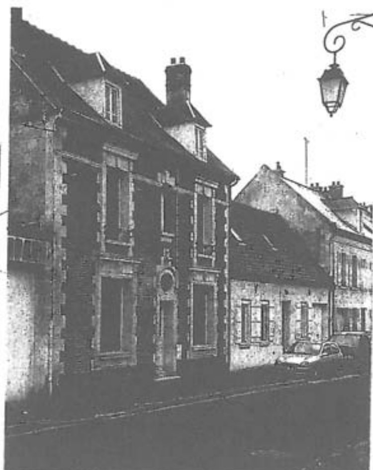
Habitat en brique avec appareillages de pierre
