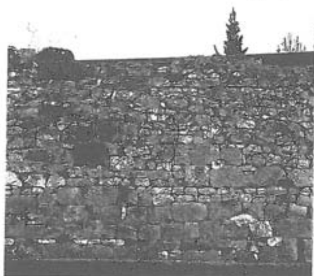
Mur traditionnel à conserver
