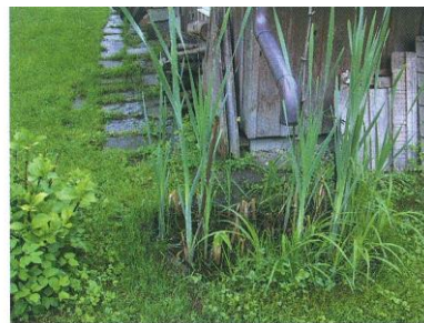
Amenagement pour un drainage naturel/ des eaux de pluie du toit
