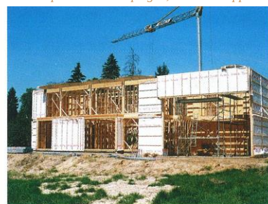
Chantier d'une maison à ossature bois
