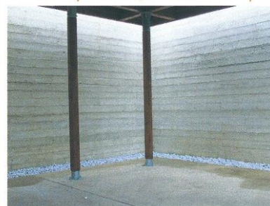
Préau aux Clayes-sous-Bois, archi. Anne Delaunay
