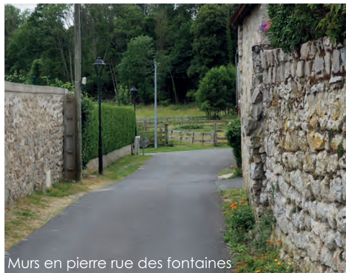
Mur en pierre rue de Varinfroy
