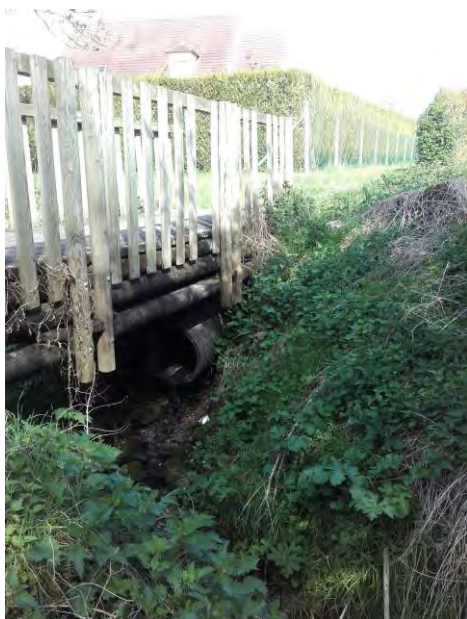
Exutoire sous la passerelle de la rue des Templiers
