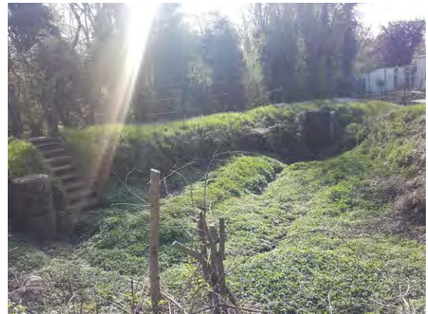
Bassin de régulation n°2
