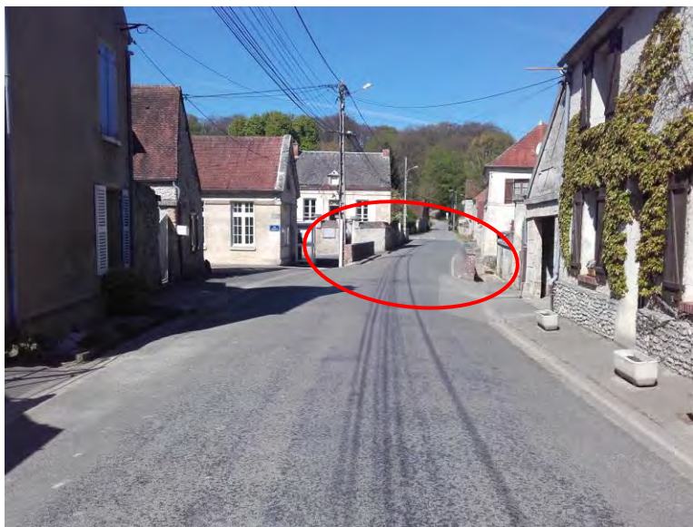
Exutoire des eaux pluviales vers le Ru de Moineau
