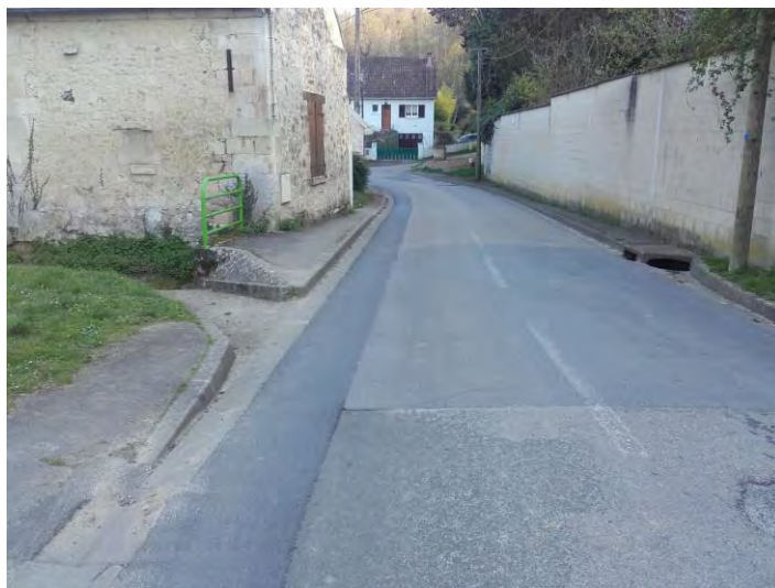
Eléments d'évacuation des eaux pluviales sur la rue de Rantigny
