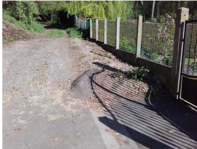
Aménagement d'un bourrelet de protection afin de dévier les ruissellements
