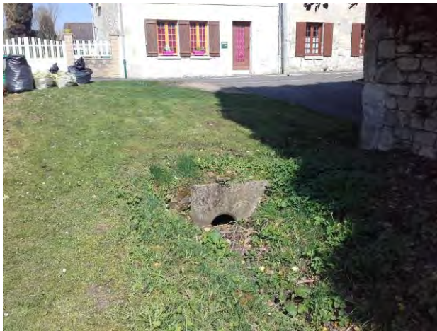
Exutoire du réseau pluvial de la rue de Liancourt
