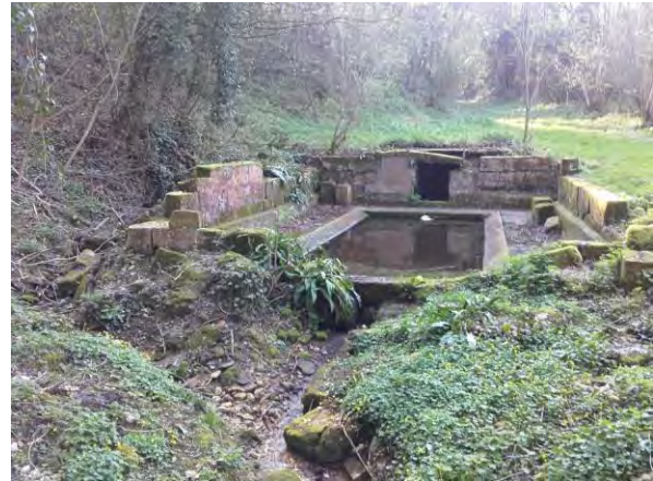
Source du Rayon à l'amont du château de Vaux
