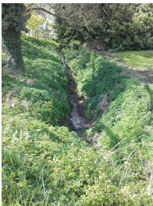
Exutoire du réseau pluvial de la Grande Rue vers le terrain de foot
