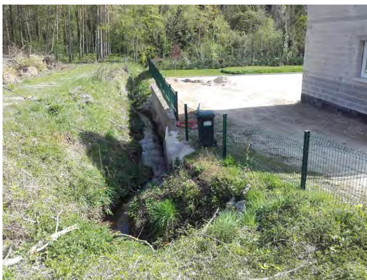
Exutoire de la rue de l'Eglise
