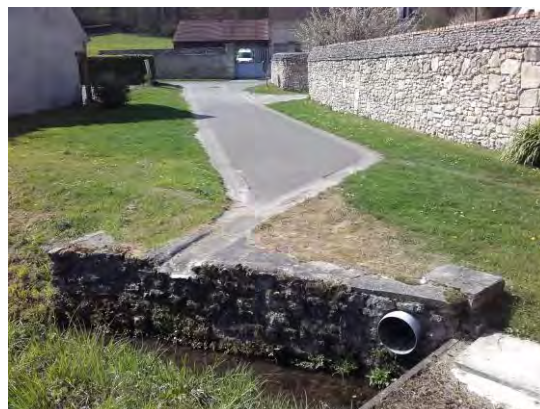
Exutoire du réseau de la Grande Rue
