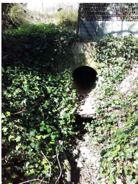
Exutoire du réseau pluvial de la rue des Carrières
