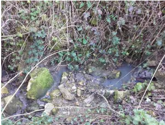
Exutoire du réseau pluvial de la rue de Vaux
