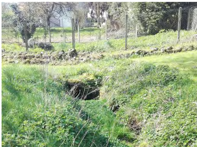
Exutoire du réseau pluvial de la rue du Couvent
