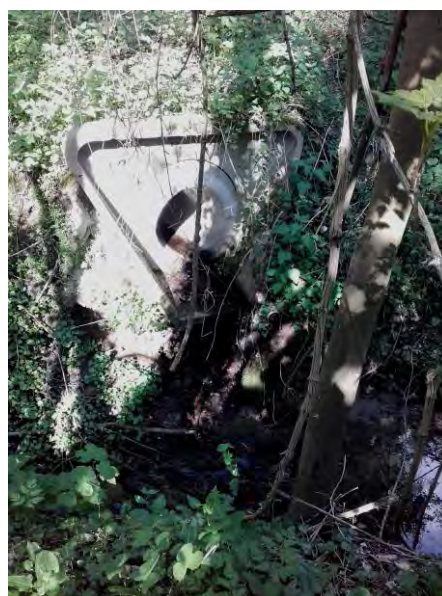
Exutoire du réseau pluvial de la rue de la Commanderie derrière le terrain de pétanque
