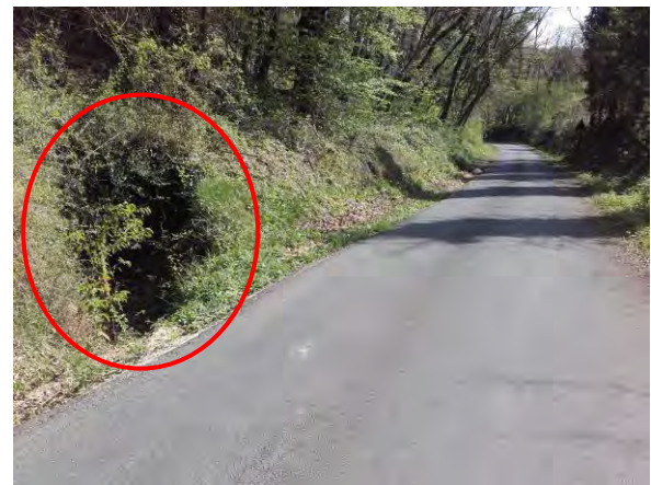
Empochements en bordure de la rue d'Auvillers
