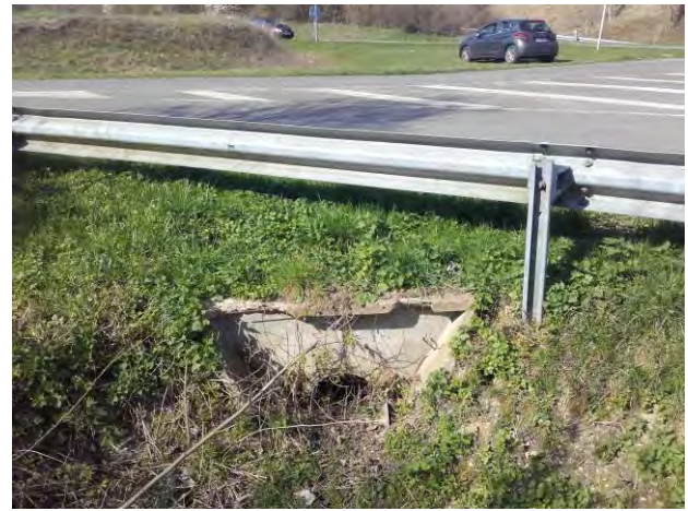
Exutoire du réseau pluvial du carrefour de la RD137 – Route de Noailles à Maimbeville
