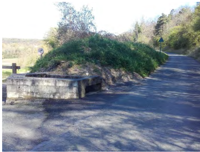
Ouvrage béton pour le tamponnement des eaux pluviales
