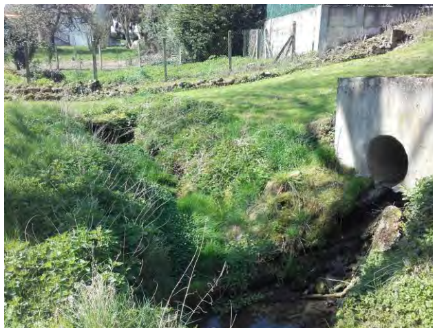
Exutoire du réseau pluvial de la rue de Mouy
