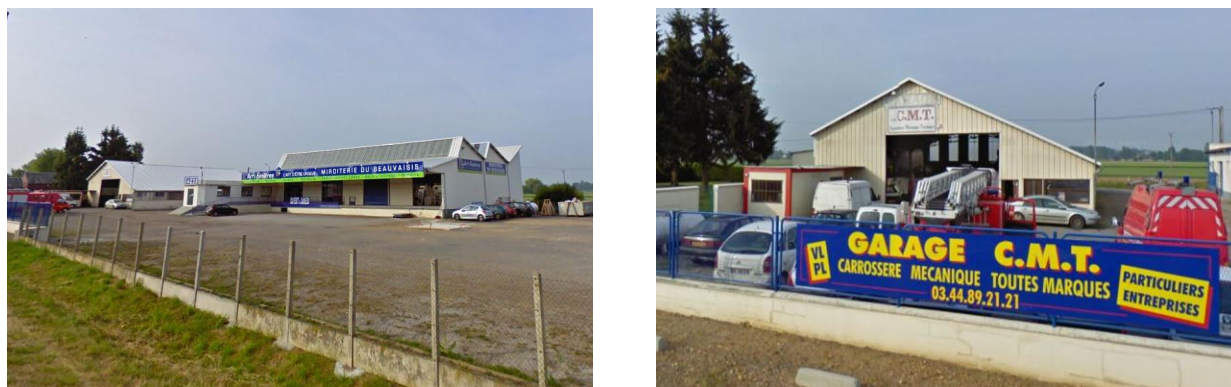
Bâtiments à usage d'activités le long de la RD 1001
