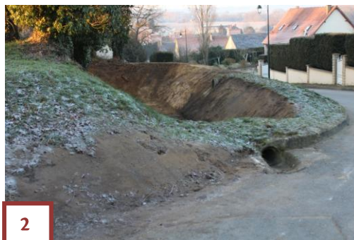
Bassin d'orage réalisé sur le Chemin des Novalles
