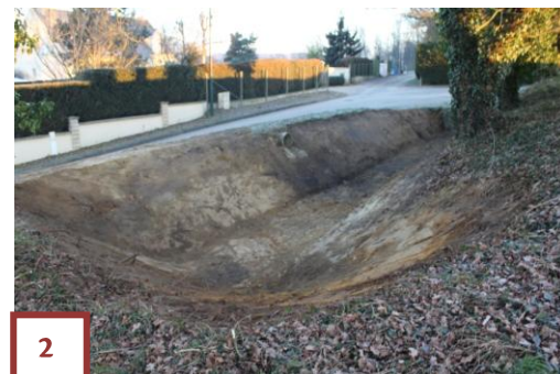
Bassin d'orage réalisé sur le Chemin des Novalles
