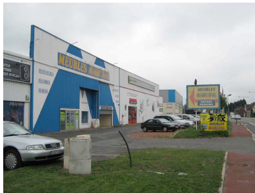
A éviter : les façades commerciales à traitement architectural sommaire et à publicité tapageuse.
