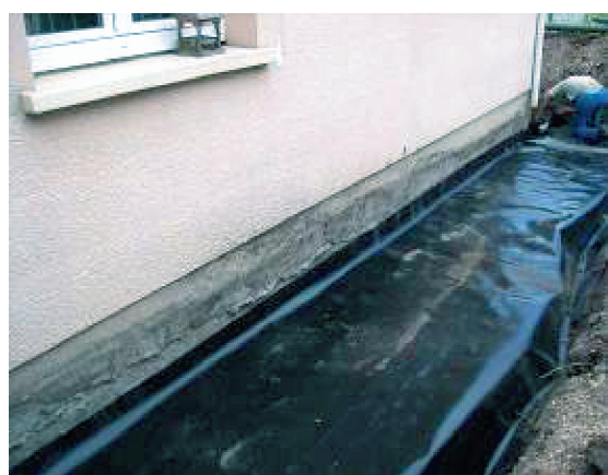
Figure 22 Géomembrane en cours de pose (Source Socabat)
