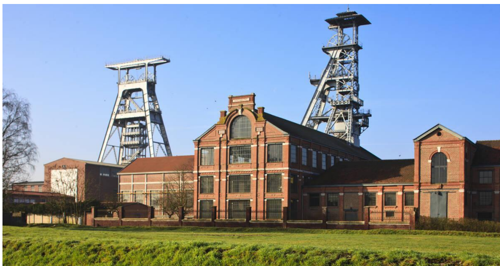
Figure 24 - Bassin minier du Nord-Pas-de-Calais
