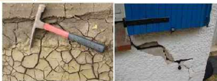
Schéma illustrant le fonctionnement de l'aléa retrait/gonflement des argiles et
