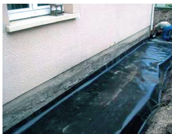
Figure 22 Géomembrane en cours de pose (Source Socabat)
