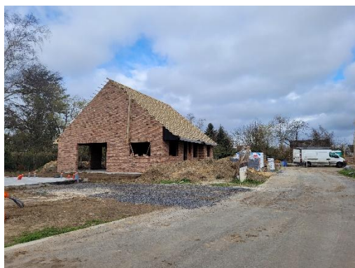
Figure 5 - Construction d'un nouveau logement en cours
