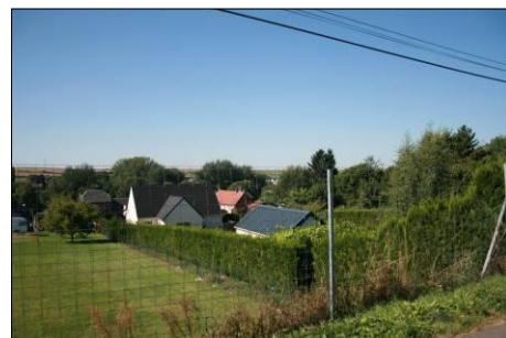
Un dénivelé soudain au bord de la RD
