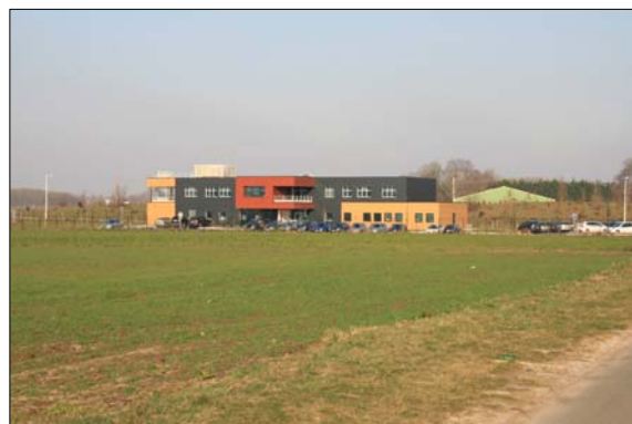
La ZAC de l'Ermitage en cours d'aménagement
