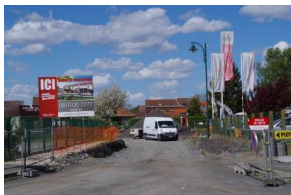
Une opération en cours d'aménagement
