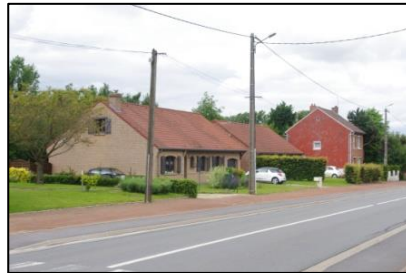
Recul des constructions neuves
