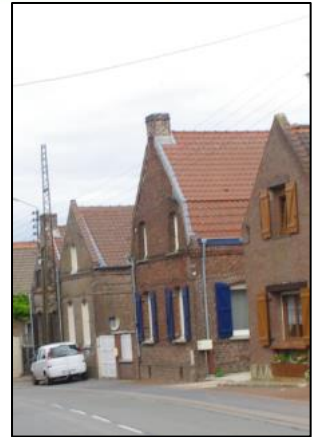
Toitures en tuiles
