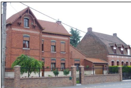
Clôture mur bahut
