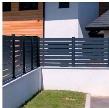
Mur surmonté d'un dispositif à claire-voie
