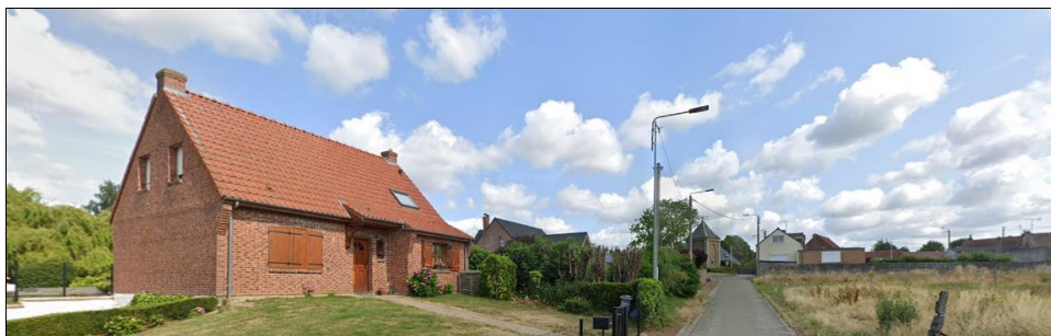
Constructions rue du Bois
