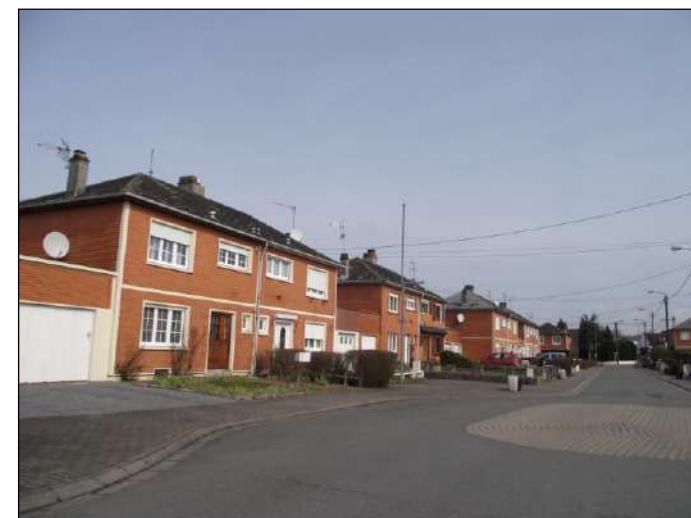
Logements GMF rue Victor Hugo
