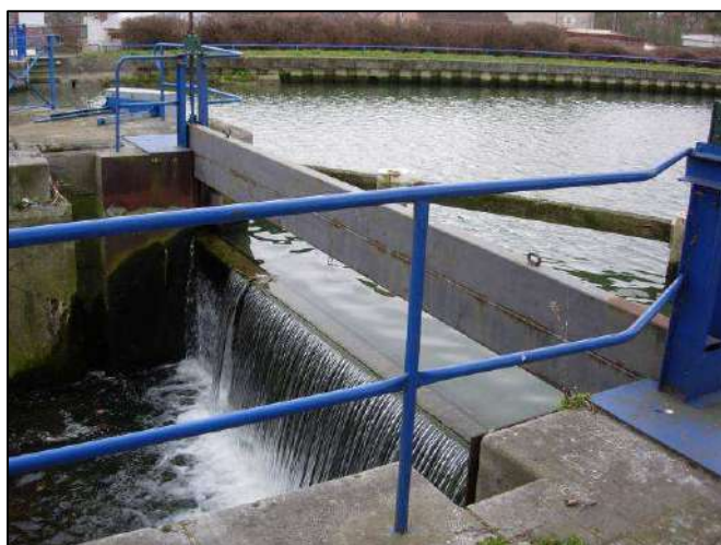
Ci-dessus : Barrage (clapet)
