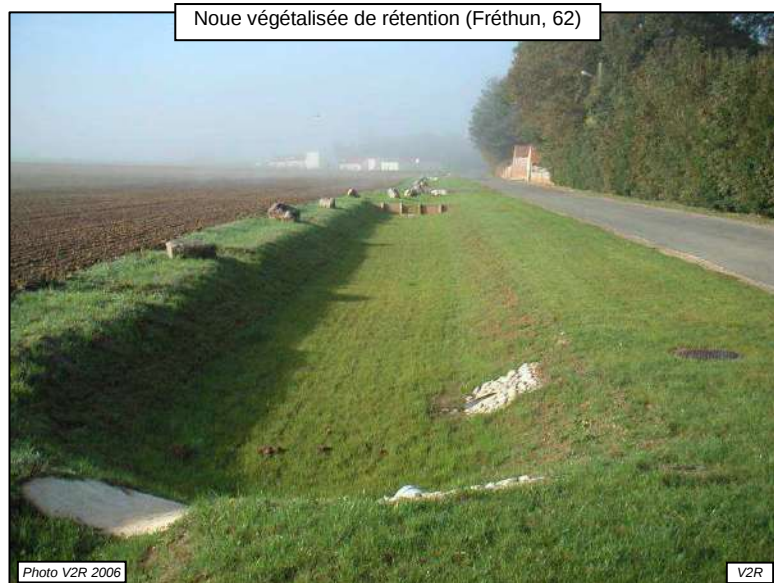
Noue végétalisée de rétention (Fréthun, 62)
