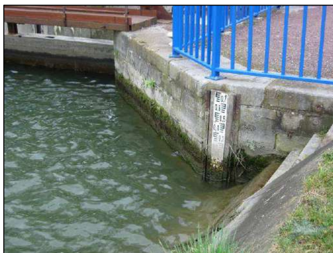
Ci-dessus : mire graduée de niveau d'eau
