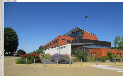
Le site du collège au Sud-Est, en venant du centre village
