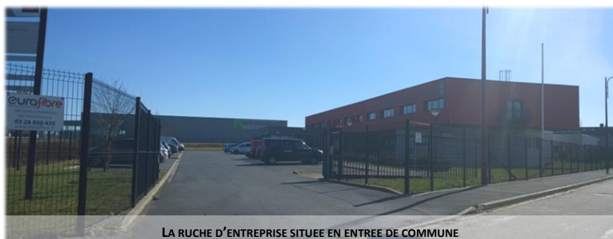
LA RUCHE D'ENTREPRISE SITUÉE EN ENTRÉE DE COMMUNE
