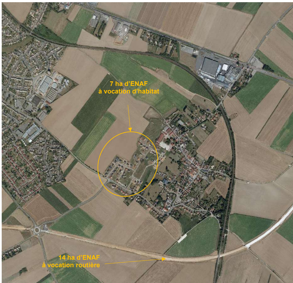
Figure 4 : Travaux du contournement de Cambrai – Sud d'Awoingt (Géoportail, 2008).
