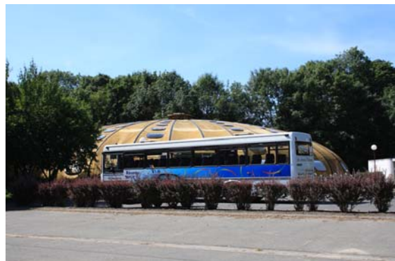
Piscine en cours de rénovation
