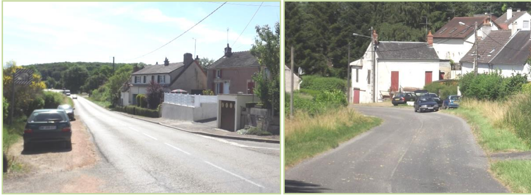
Exemples de voiries sans aménagements doux et dont les cheminements piétons ou cyclables sont rendus difficiles par le stationnement le long des voies (à la Grippe à gauche et au Grand Gué d'Heuillon à droite)
