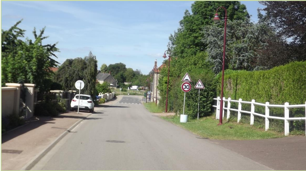
RD148 : Exemple de la traversée du centre-bourg
