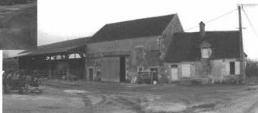
Bâtiment de stockage et stabulation accolée
