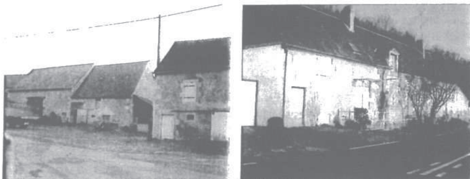
Présence de tuiles et d'ardoises
