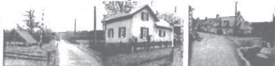
traverse Poiseux et dessert la gare et ... Mauvron
