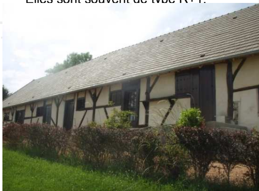
Construction à pans de bois Source Topos
