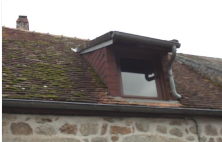
Photo de toiture en tuiles de bourgogne (crédits CDHU)
