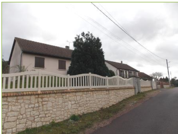
Photo des pavillons des années 1980-1990 sur le boulevard de la Chamaille (crédits CDHU)
