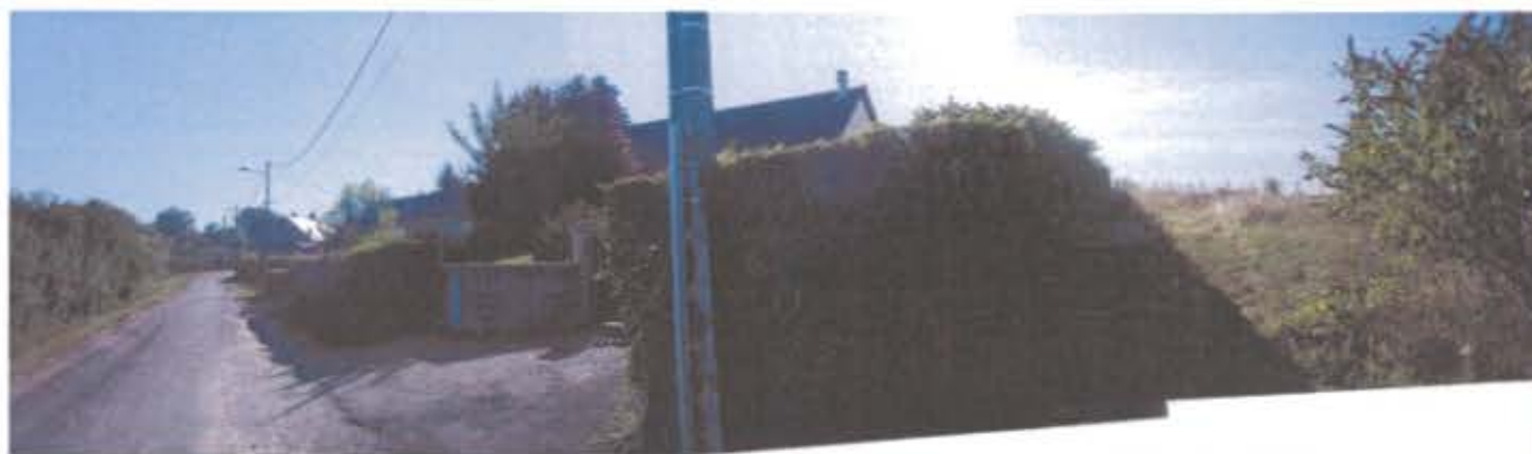
Le long de la VC N°1 de Guérigny à la Quellerie : habitations en zone « UD » du PLU
