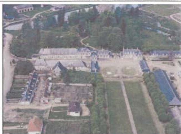
Les Forges Royales : les origines de Guérigny Entrée des anciennes Forges royales de la Chaussade et du « Vieux Guérigny ».
