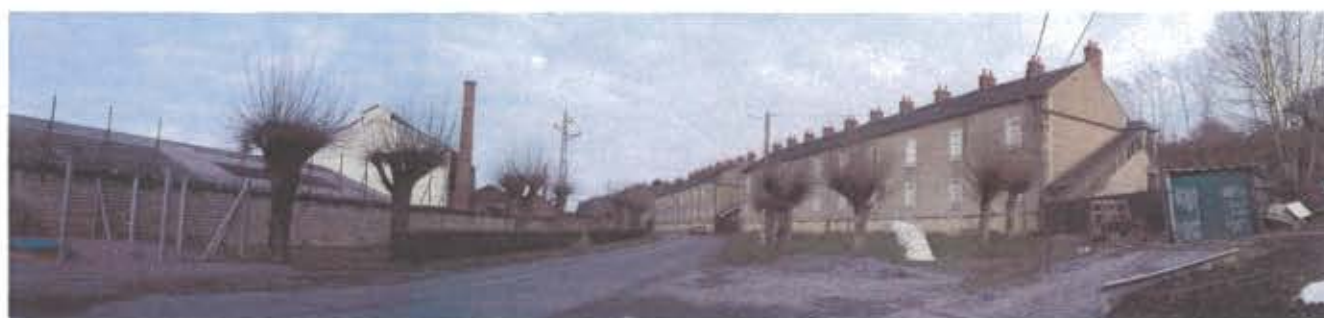
Les Chambres Neuves : une surface importante de logements collectifs vacants à réhabiliter
