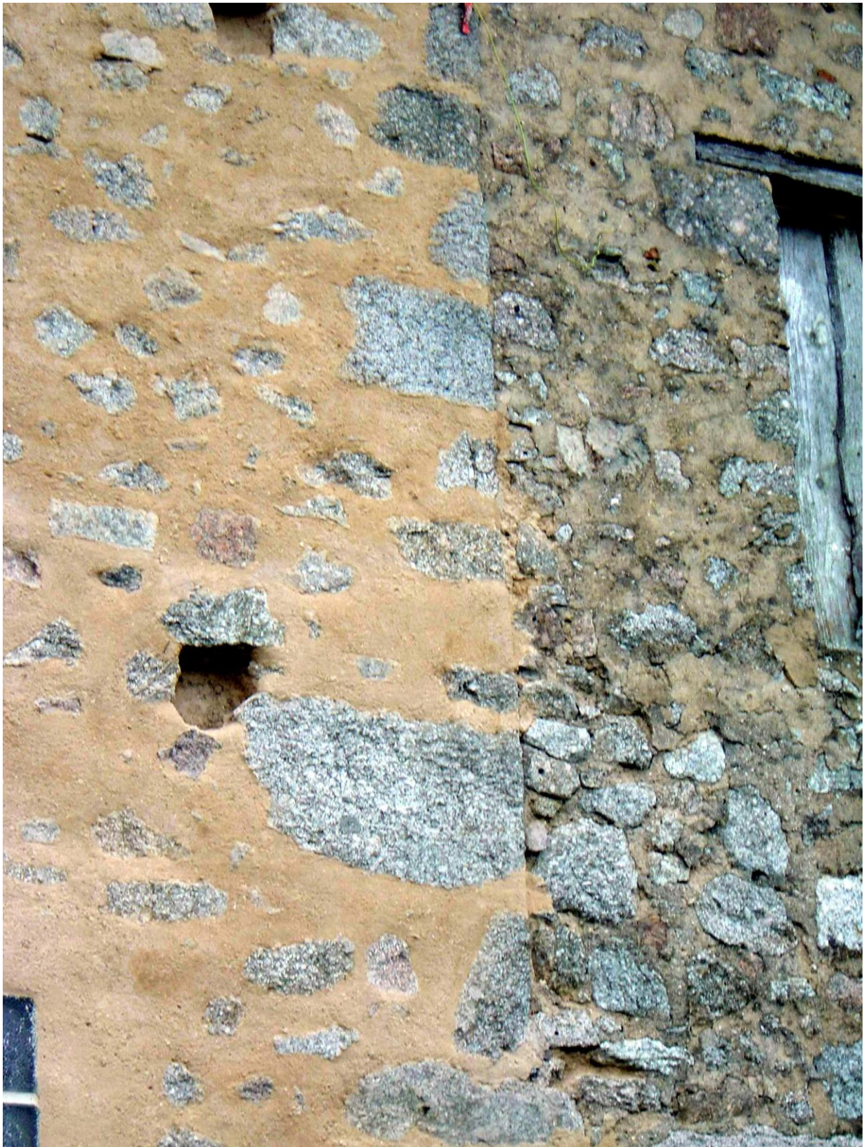
Exemple d'enduit sur mur à Pierre vue
