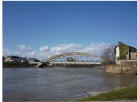
Pont du 152e R.I.
