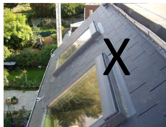
Vélux non encastrés à impact visuel fort. www.idealtoitures.com
