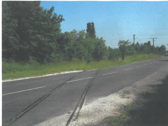
Le franchissement de la rue LaFayette, accès au chemin des Prés Maillard et à la zone commerciale sud. A aménager et sécuriser.
