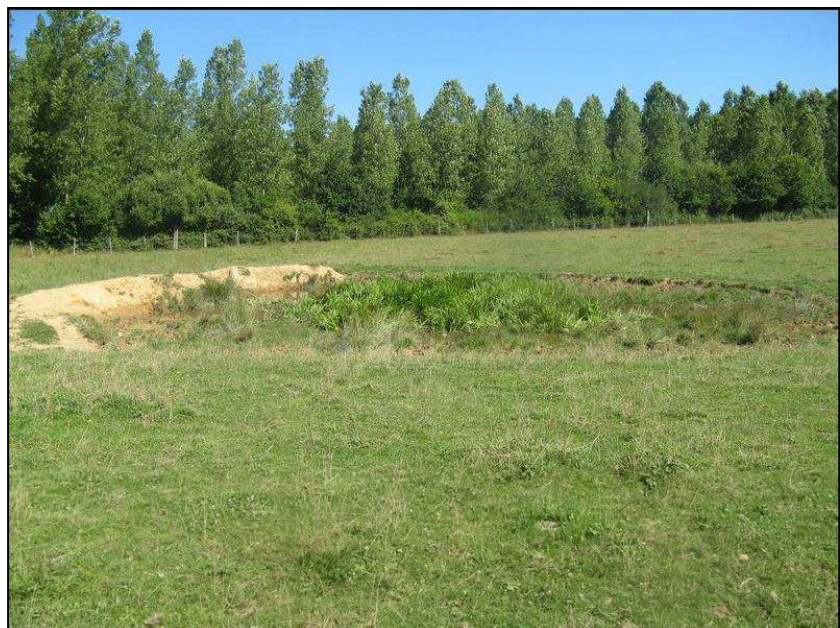
Prise de vue de l'effondrement à CORBIGNY
