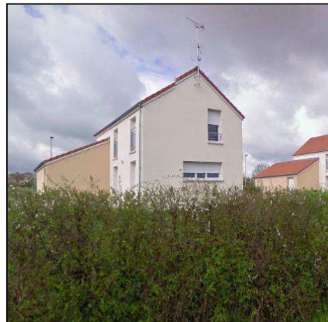
Construction pavillonnaire récente
