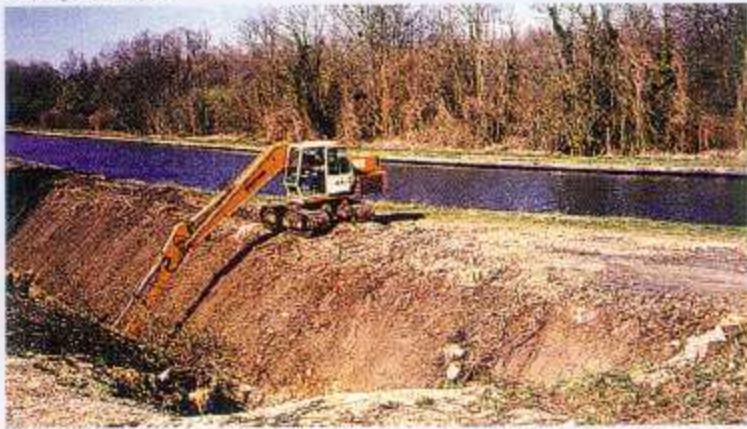
Talutage de digue.
