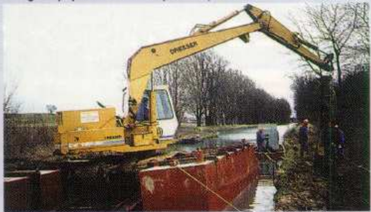
Battage de palplanches avec une pelle sur ponton.
