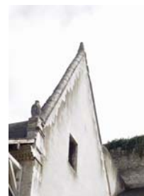
Rue des Hôtelleries
