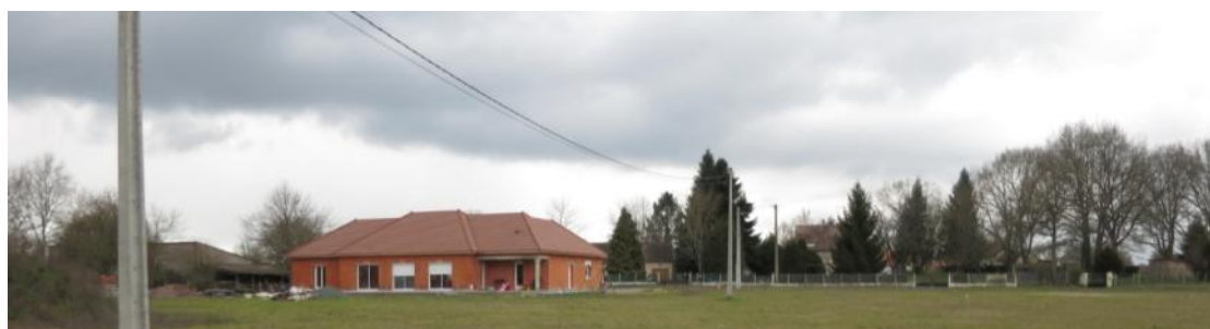
Maison en construction au hameau Le Rio
