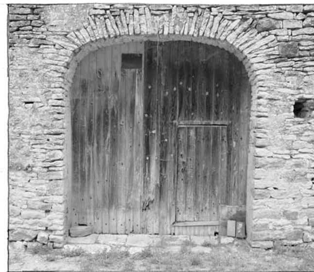
Arc en anse de panier en pierre calcaire
