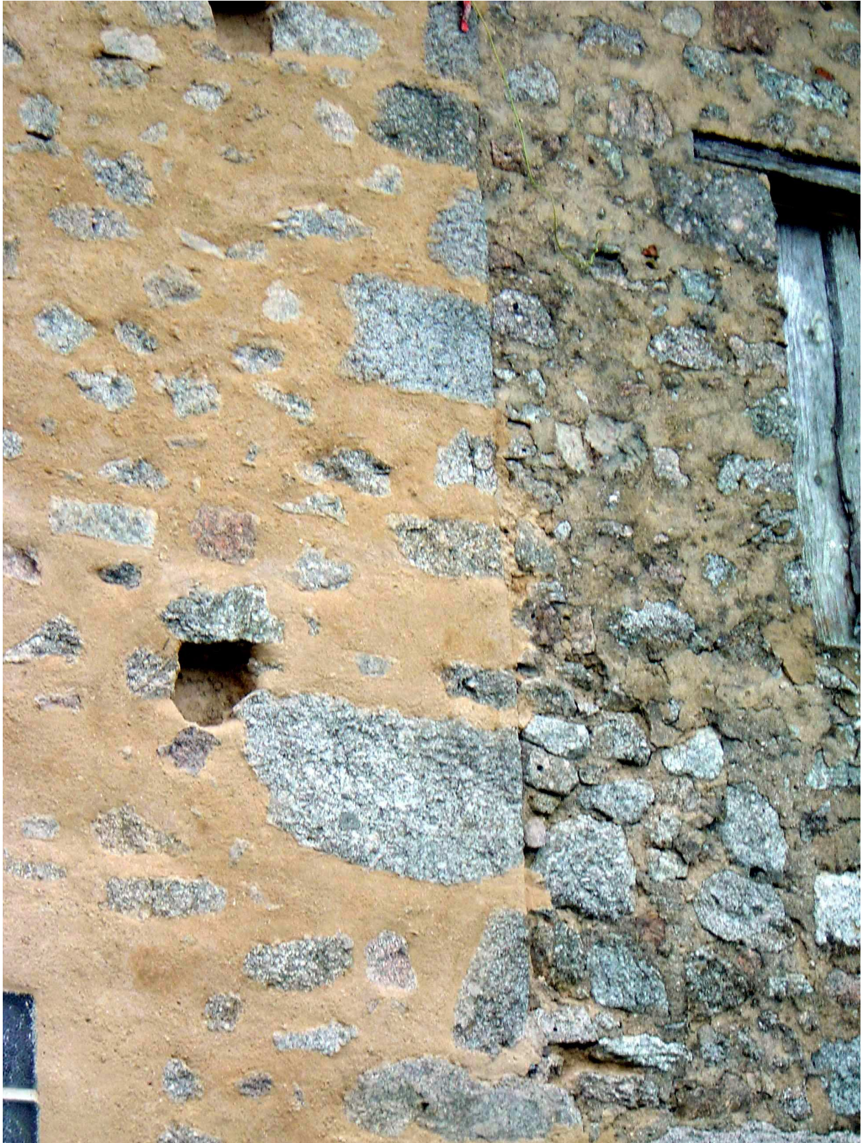
Exemple d'enduit sur mur à Pierre vue
