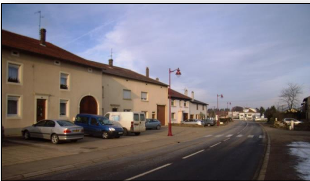
Constructions mitoyennes « décalées » rue de la liberté
