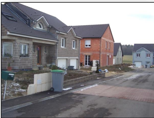
Maisons en constructions, boucle du clos des prés
