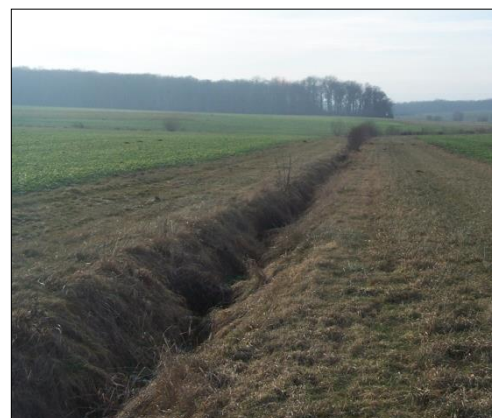
Un fossé sur la commune de STUCKANGE
