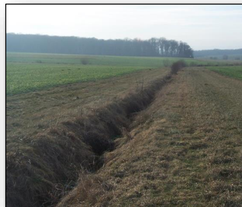
Un fossé sur la commune de STUCKANGE
