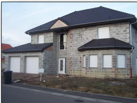
Maison en construction rue des acacias
