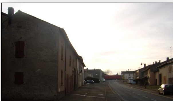
Constructions mitoyennes alignées rue de la liberté
