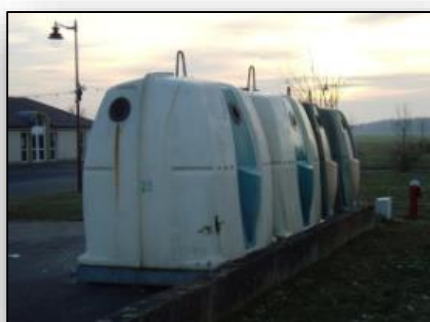
Point de collecte des déchets, rue des lilas
