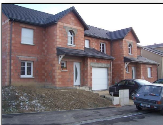
Maisons jumelées en construction, rue des acacias
