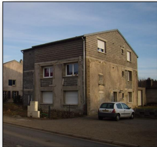
Des maisons rénovées à STUCKANGE
