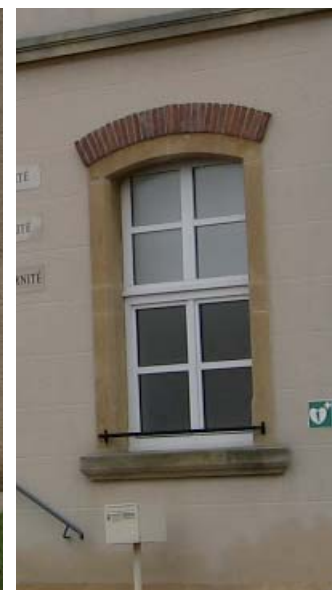
Détail en briques
