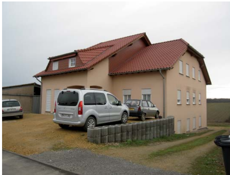
Collectif rue des Févières
