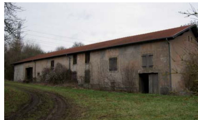
Ancien corps de ferme à Lavieuville
