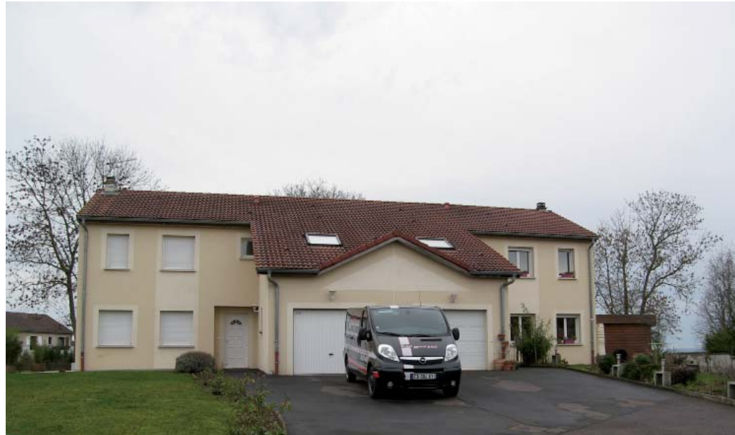
Bâti construit en ordre semi continu (maisons jumelées) dans la rue du Château à Vry
